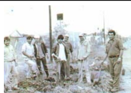
Foto N°1. Comisión de obras 1984
