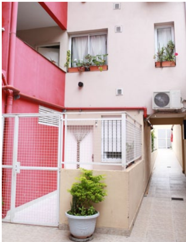
Patio interno y pasillo de circulación
