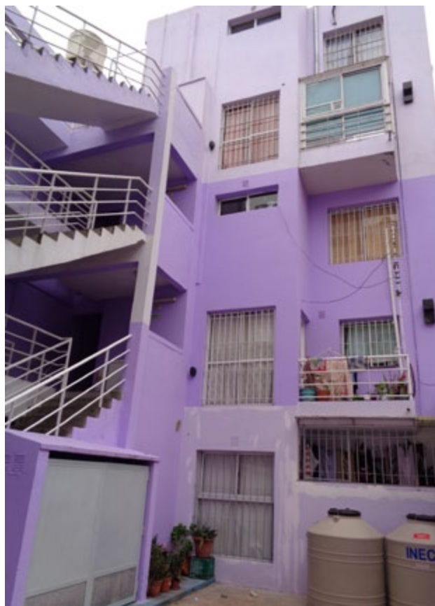
Contrafrente del complejo habitacional
