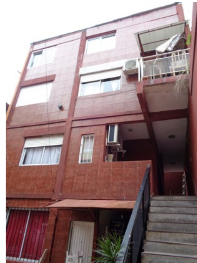
Contrafrente del complejo habitacional
