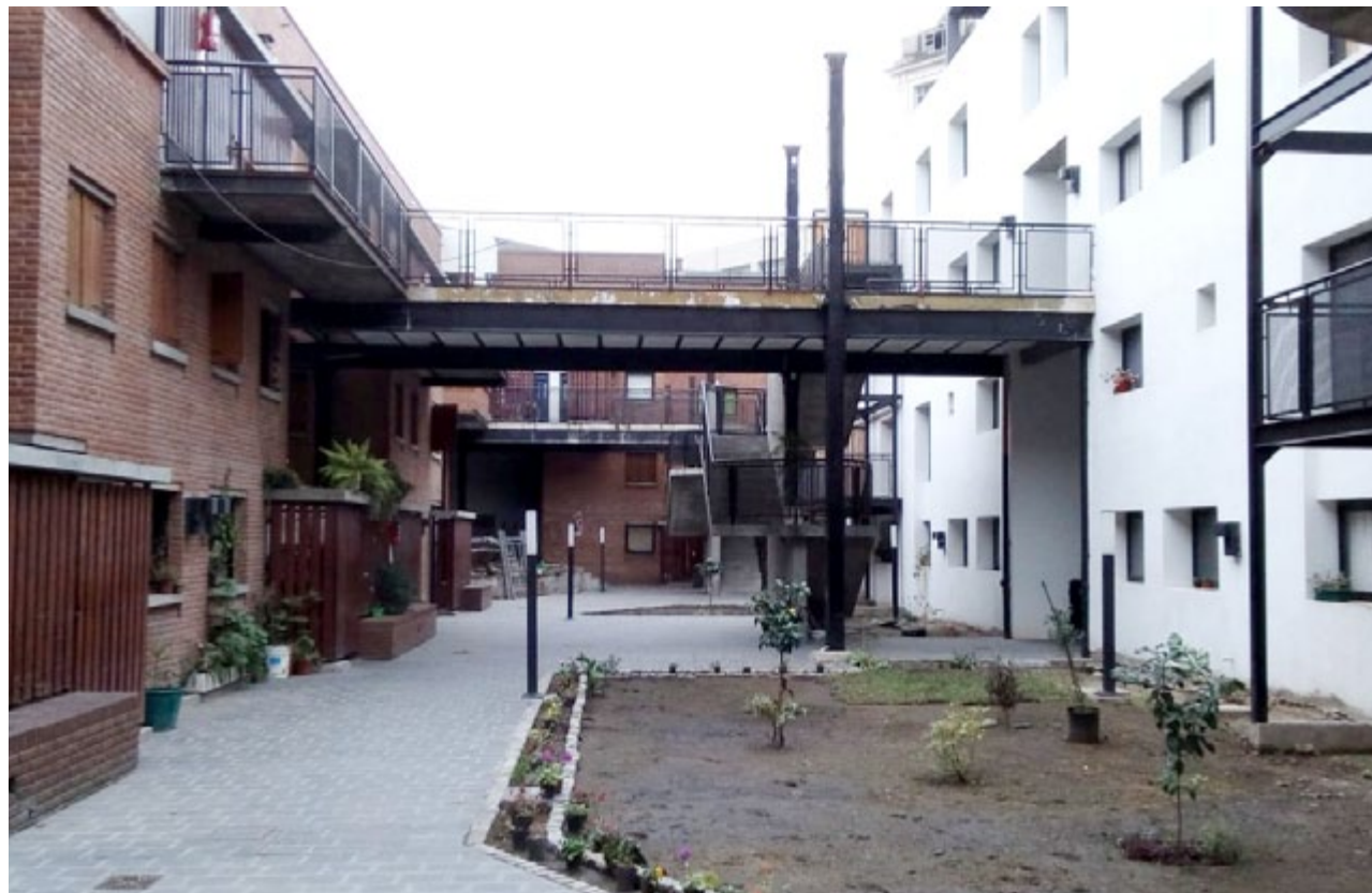
Pasillo interno de circulación
