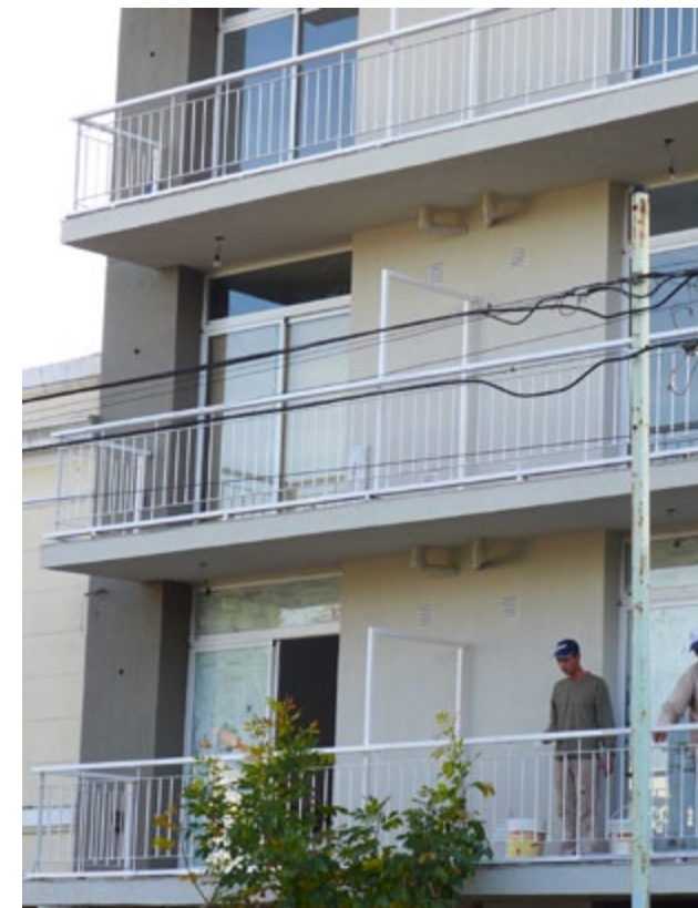
Frente del inmueble. Detalle
