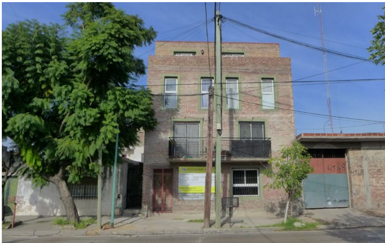
Vista fachada del inmueble
