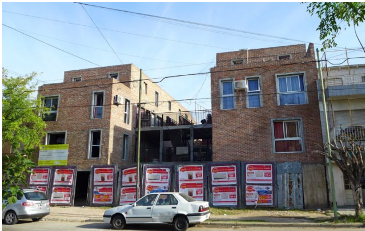
Vista fachada del inmueble
