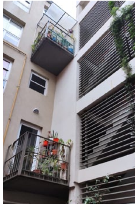
Vista desde pasillo interno
