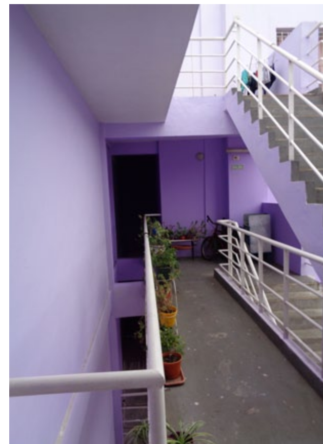
Pasillo interno de circulación
