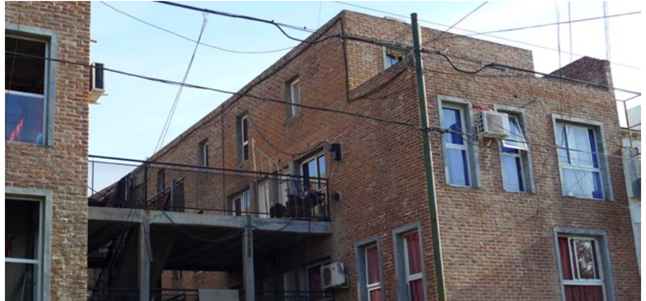
Vista lateral interno del inmueble
