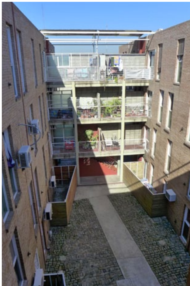
Vista panorámica patio interno
