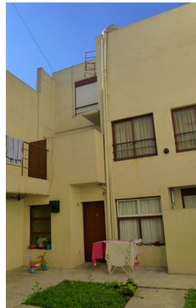
Contrafrente del complejo habitacional
