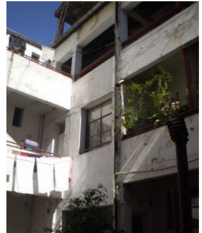
Cooperativa La Unión, interiores rehabilitado.
