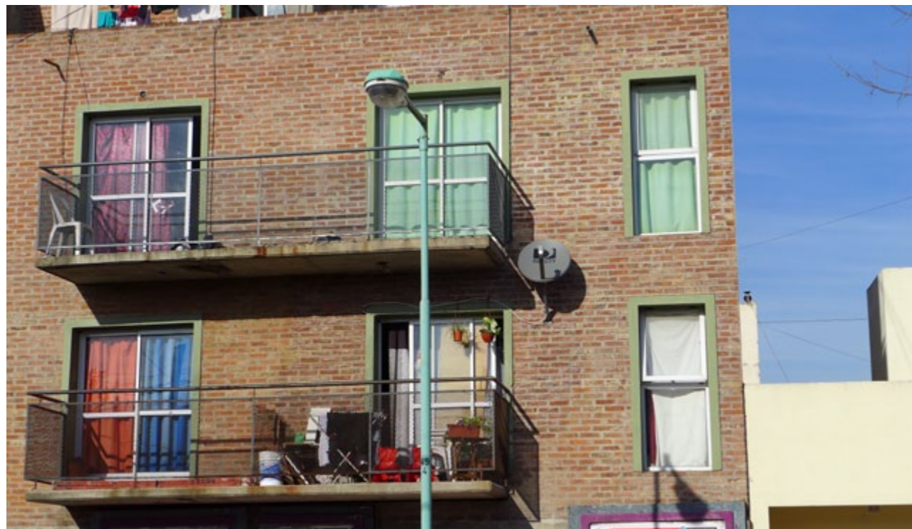
Vista detalle fachada
