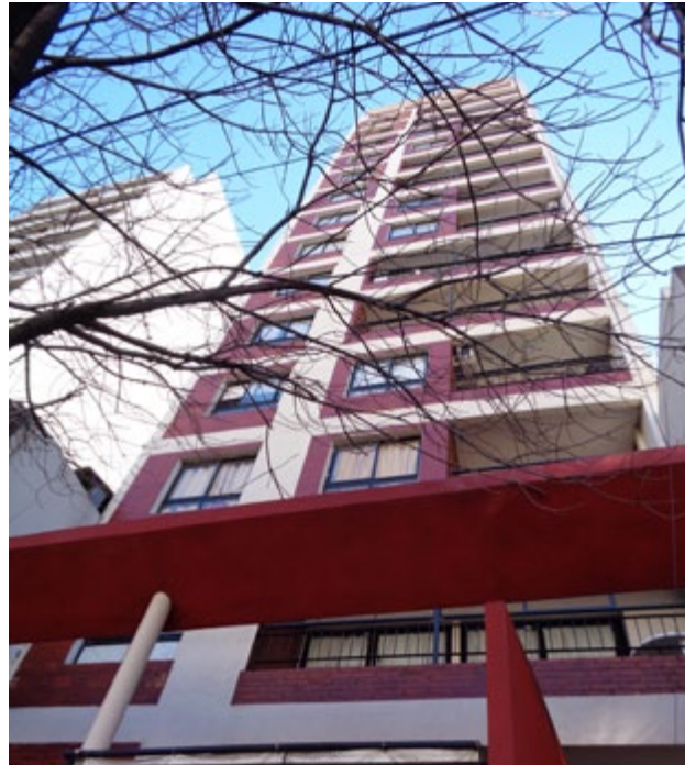
Fronte del inmueble
