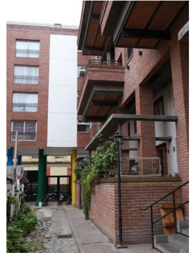
Pasillo interno de circulación
