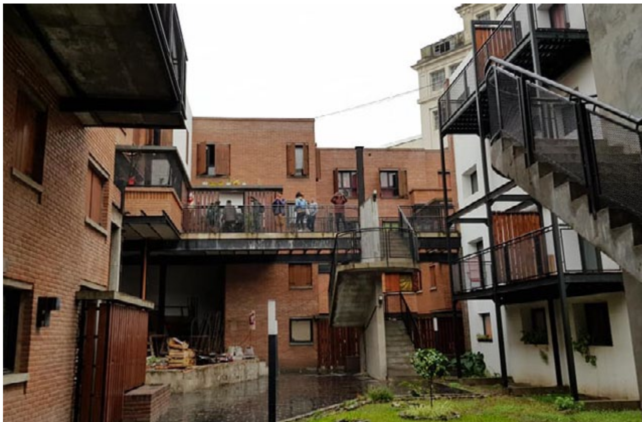
Pasillo interno de circulación
