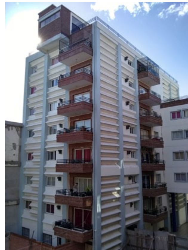
Contrafrente del complejo habitacional
