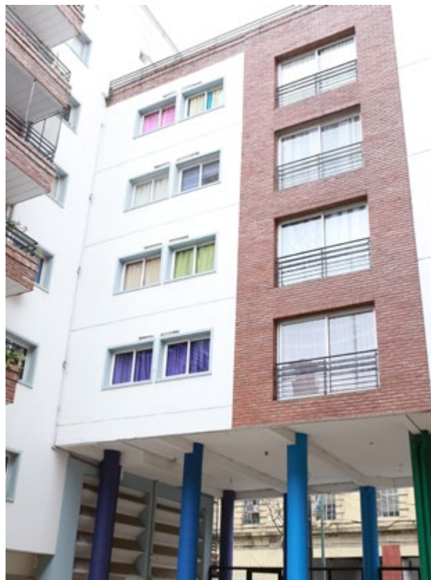
Contrafrente del complejo habitacional
