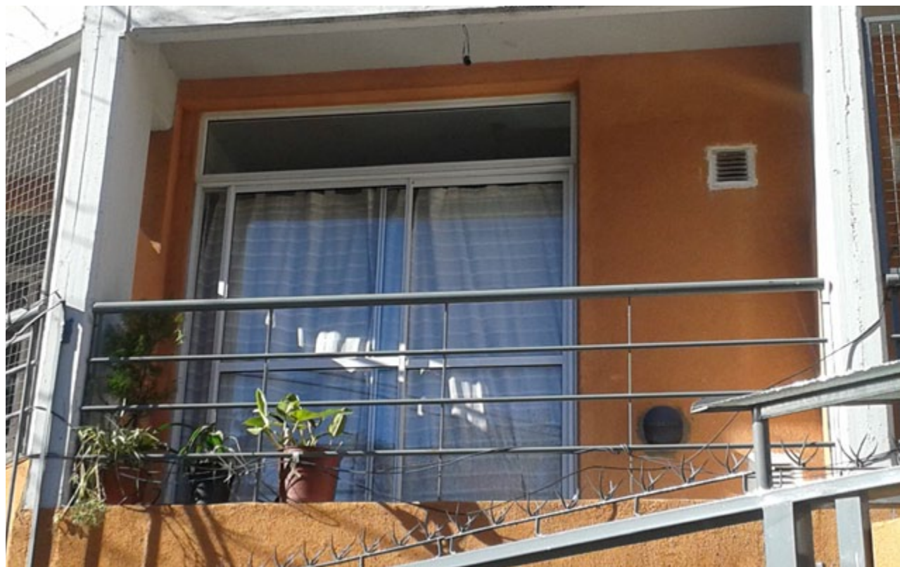
Frente del inmueble. Detalle
