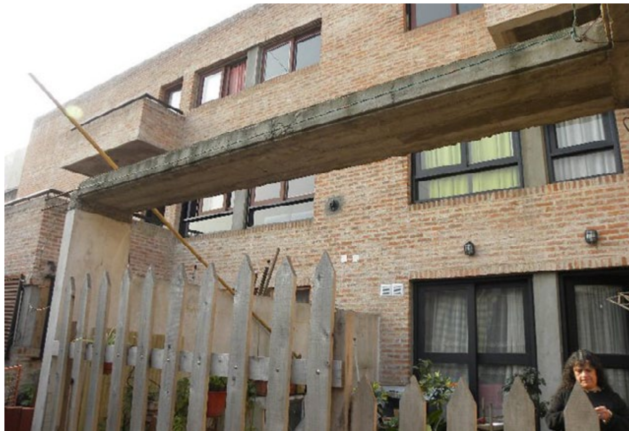
Frete lateral interno del inmueble en obra
