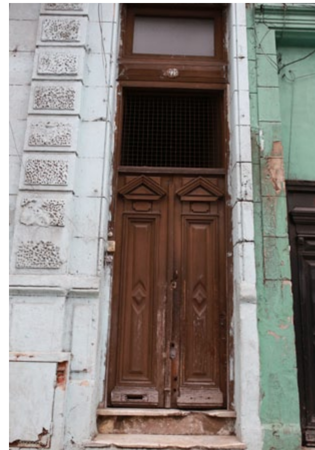
Entrada inmueble de atrás
