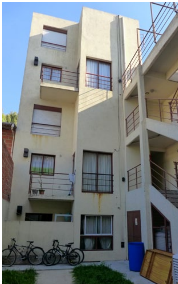
Contrafrente del complejo habitacional
