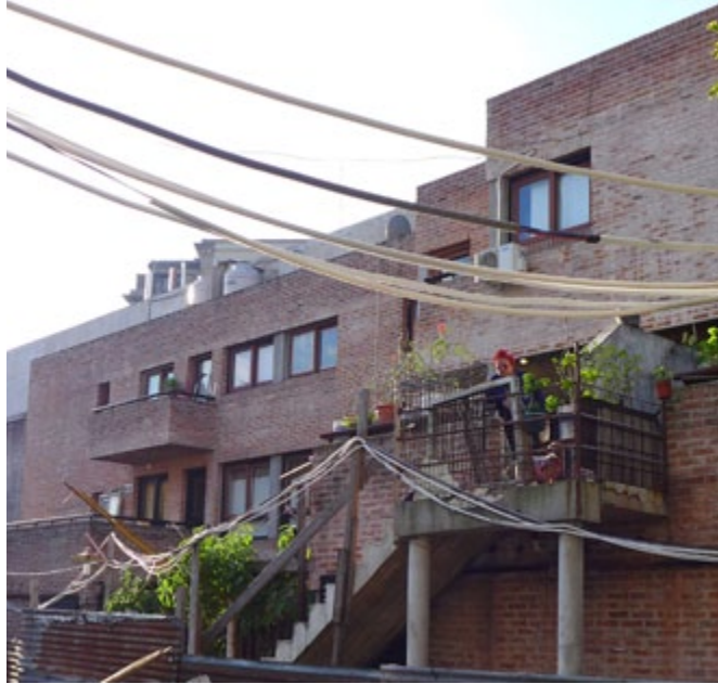
Frente lateral interno del inmueble en obra
